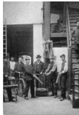
Atelier dans la cour de la maison de la rue du May, escalier menant aux dortoirs, vers 1900.
