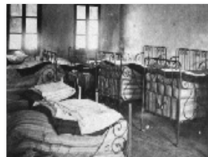
Dortoir de la maison de la rue du May, vers 1900.
